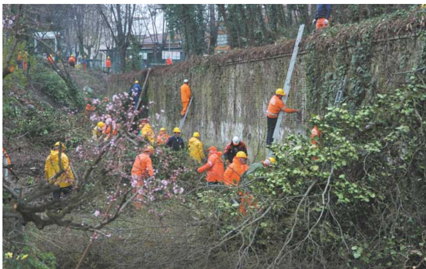
Il muro perimetrale della fortezza durante la bonifica.
