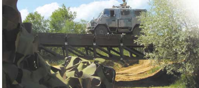
Un veicolo blindato attraversa il ponte appena costruito dai genieri guastatori del 32° battaglione della brigata alpina "Taurinense".
