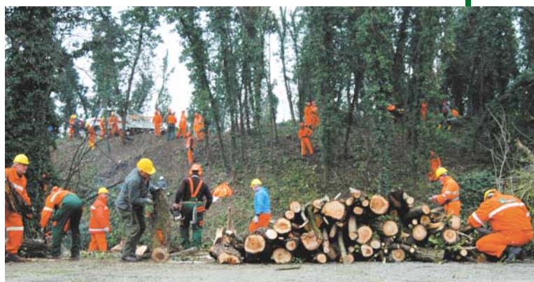
Un interno della Cittadella. I tronchi recuperati durante la bonifica, tagliati e accatastati, pronti per il trasporto.
