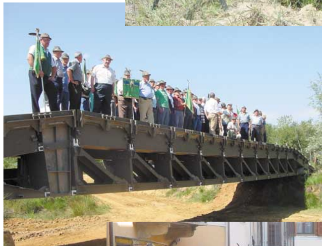
A sinistra: che soddisfazione vedere che il ponte... regge.
